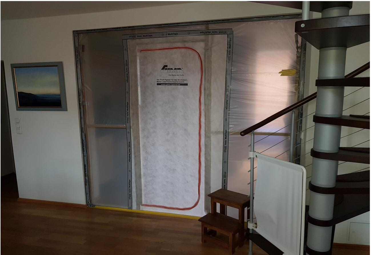
*Abbildung 2: Abschottung der Sanierungsbaustelle. Erstellt NACH den Demontearbeiten erst am 19.6.2020.*
