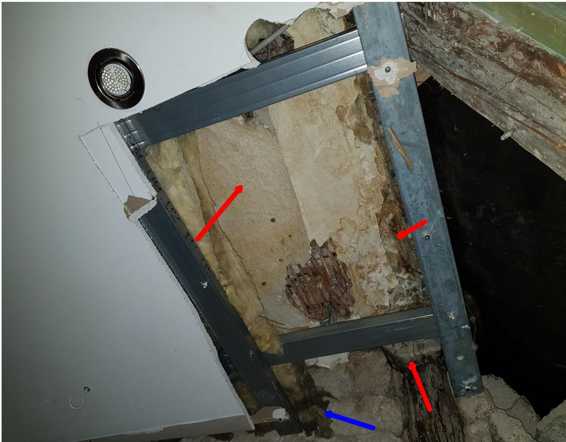
Abbildung 3: Küche, Decke über der Küchenanrichte. Rote Pfeile = feuchtes und schimmeliges Material. Blau = KMF, Einbaudatum unklar, bzw. evtl. ebenfalls verschimmelt
