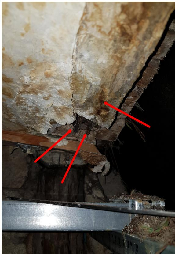
Abbildung 4: Detailfoto zu Abb. 3, Sichtbarer Schimmelbefall am Putz und den Schilfrohren des alten Deckenmaterials
