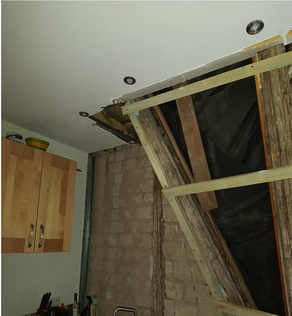
*Abbildung 1: Demontierter Sanierungsbereich in der Küche, offen zugänglich und nicht restlos gereinigt*
