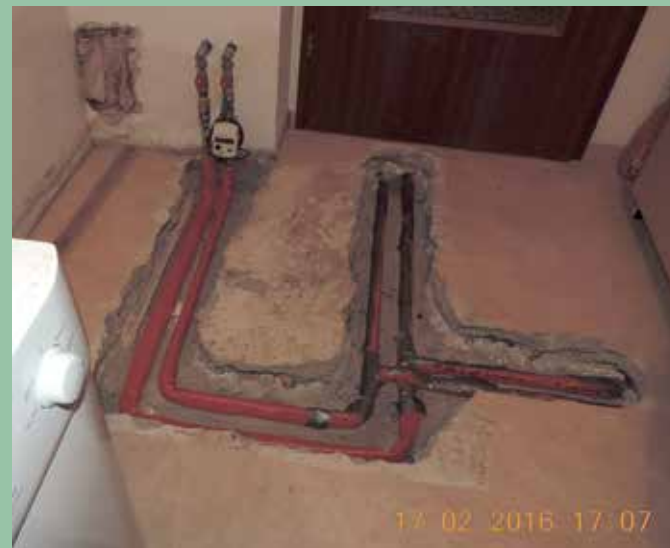
Unsachgemäßes Trocknen und Sanieren in einer Mietwohnung
