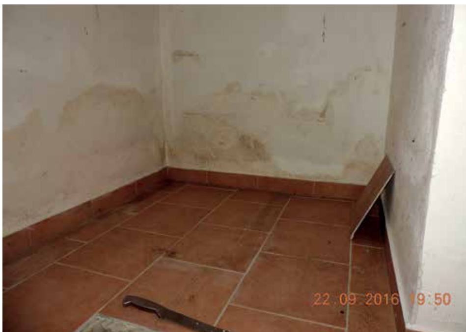
Treppenhaus im Keller mit Feuchteschäden
