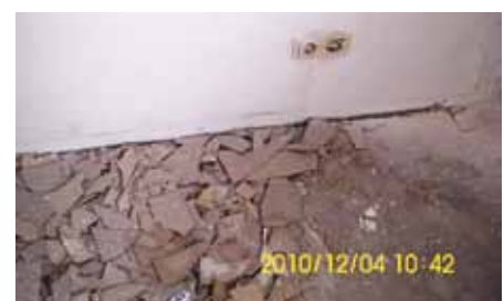
Unsachgemäß bearbeitete Bodenbeläge mit Asbest
